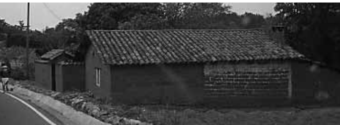
Figura 16. Viviendas en Santa Cruz del Quiché la cantidad de viviendas de adobe es menor que en Sacapulas
