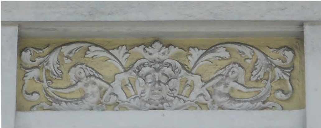
Figura 1. Detalle antropomorfo mixto (femenino y masculino) en la 9ª avenida y 4ª calle, 4-29. Antigua sede de la Central Nacional de Trabajadores (CNT), donde fueron detenidos y desaparecidos 27 dirigentes en 1980. Actualmente se encuentra abandonada.
