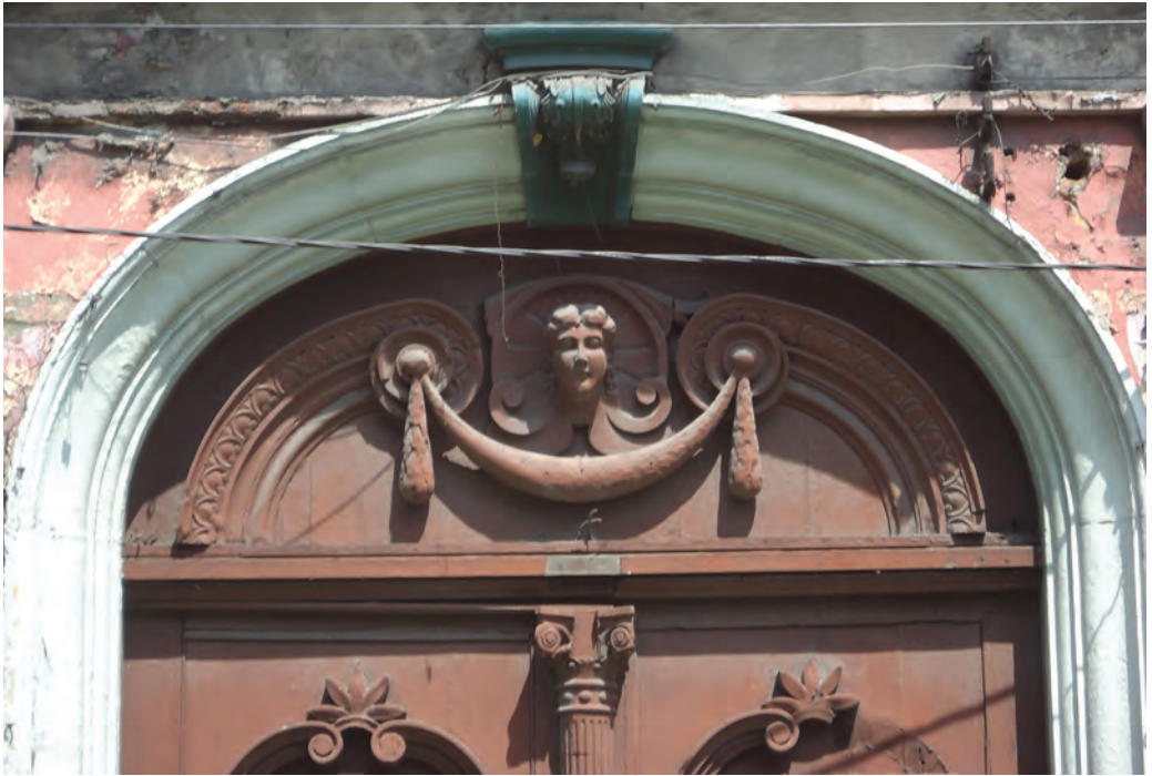
Figura 3. Detalle antropomorfo femenino, en la 5ª avenida entre 13 y 14 calle. Es el único caso registrado en madera. El edificio fue desmembrado y esta sección yace abandonada.
