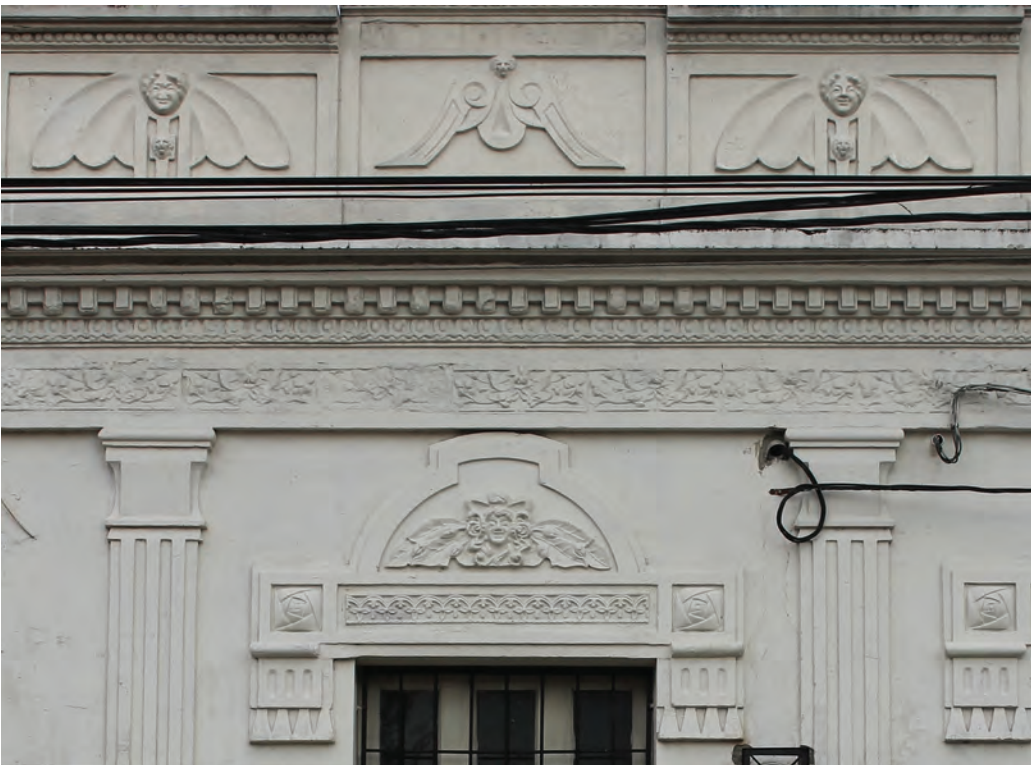
Figura 9. Detalle de la fachada en una casa sobre la 3ª avenida y 3ª calle, 3-44. Nótese que posee dos detalles antropomorfos y un detalle zoomorfo.
